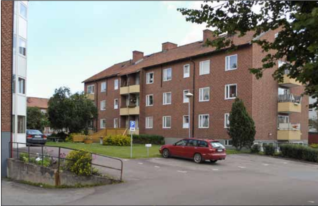
Vallen 32 (södra delen byggnad 2)
