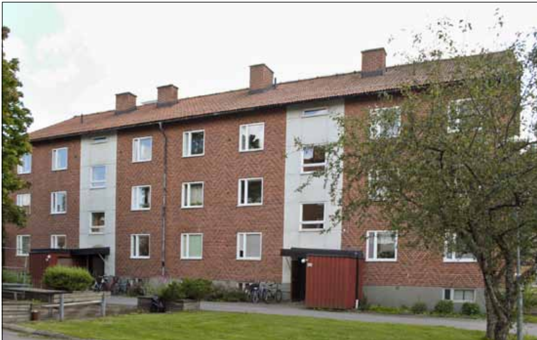
Vallen 32 (södra delen byggnad 3)
