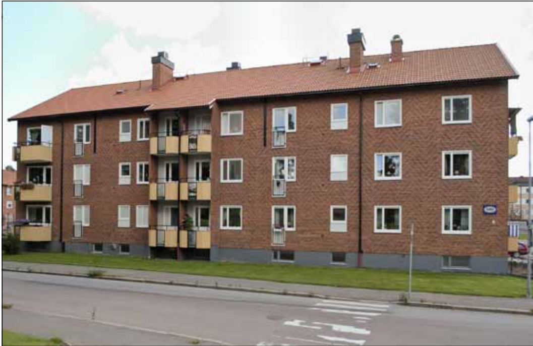
Vallen 32 (södra delen byggnad 1)
