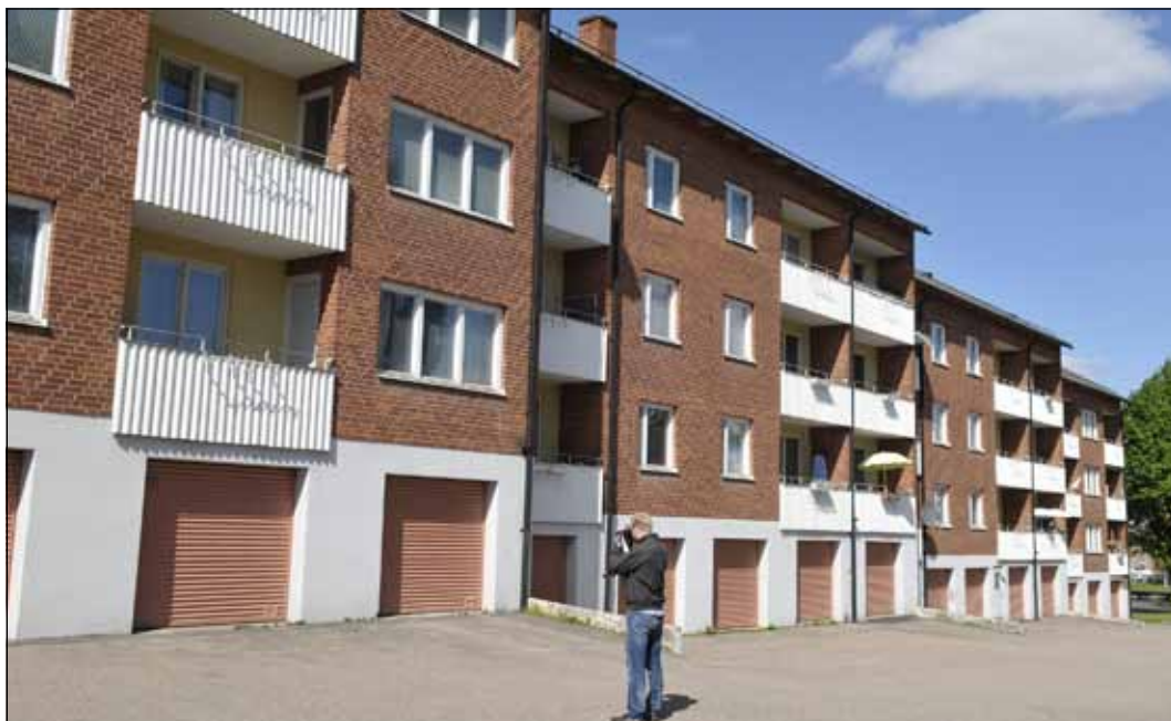
Hamnen 14, byggnad 1 (ovan och höger)
