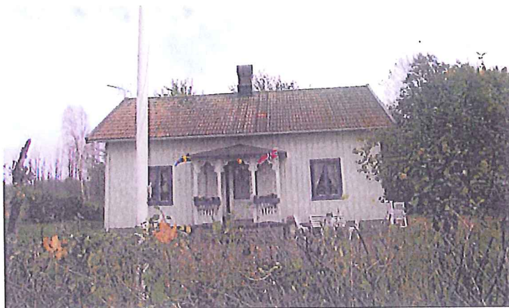
Ekenäs 1:17, beläget invid hamnen i Ekenäs, är med sin välbevarade exteriör en god exponent för sin tids husbyggande. Byggnaden och den omgivande trädgården utgör som helhet en kulturhistoriskt och miljömässigt värdefull miljö för området. Foto: Mattias Libeck
