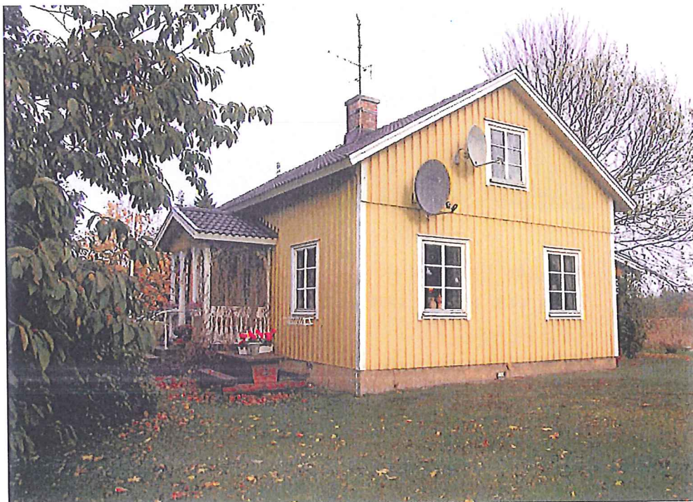
Ekenäs 2:1, ett av de två hus som ligger på platsen för gamla Ekenäs gård. Bostadshuset används idag för året runt-boende och har med åren moderniserats med nya, svängbara 1-lufts-fönster och ett nytt takmaterial i form av svartmålad s k plegel. Foto: Mattias Libeck, Värmlands Museum.
